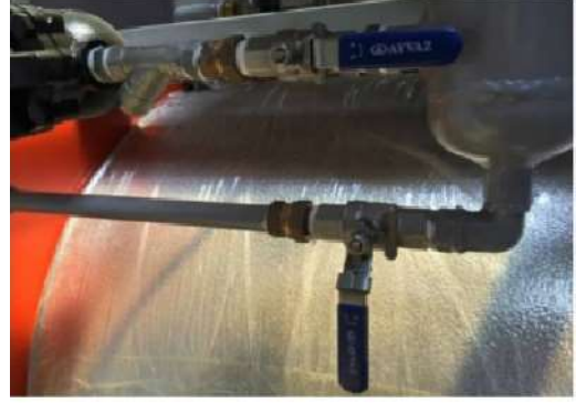
Kondenstop Grubu By-pass Vanası
